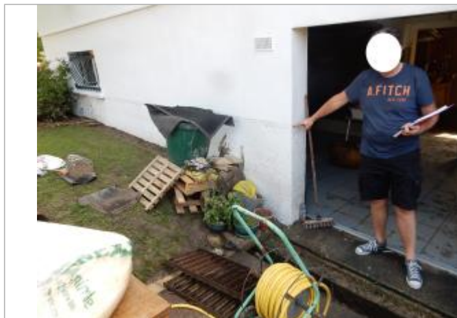
Laisse de crue à 114 cm/sol
