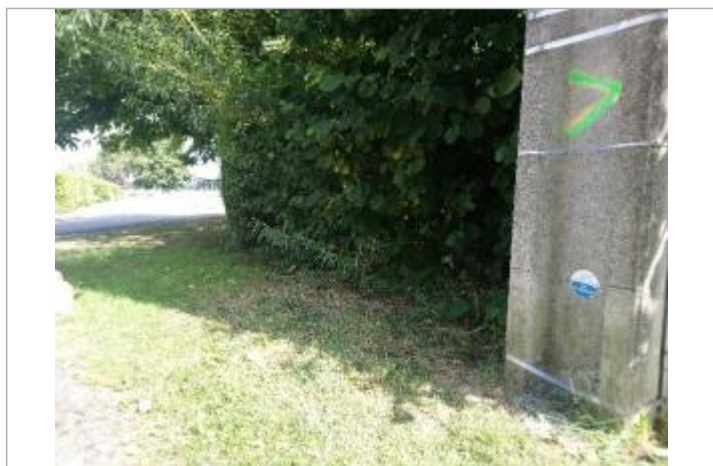
Repère de crue en rive droite de la Zerlebecque
