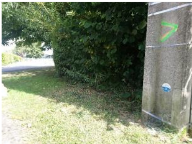
Repère de crue en rive droite de la Zerlebecque
