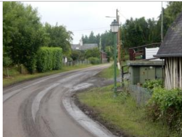
Vue depuis la rue de la Gare en venant de la rue du Clos Mesnil.
