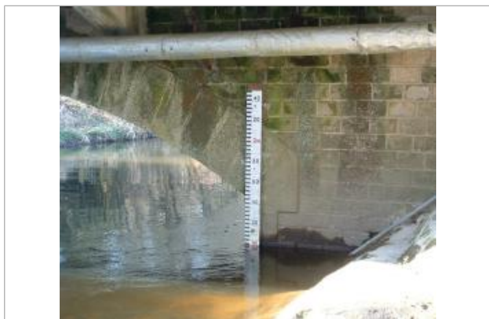
Echelle limnimétrique sous le pont de la RD 156
