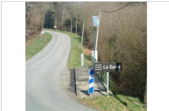
vue générale du site de la station
