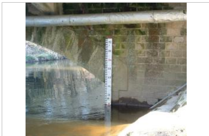
Echelle limnimétrique sous le pont de la RD 156
