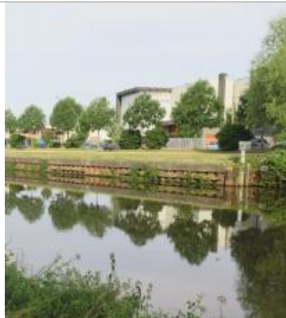
vue de la rive gauche du quai et limnigraphe sur la rive droite
