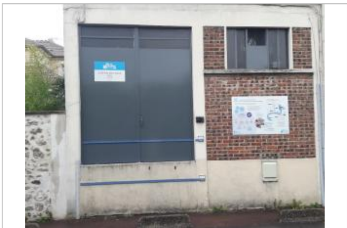
Repères de crue sur la station anti-crue du Conseil départemental du Val-de-Marne
