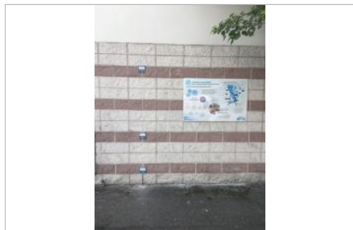
Repères de crue sur la station anti-crue départementale La Fontaine
