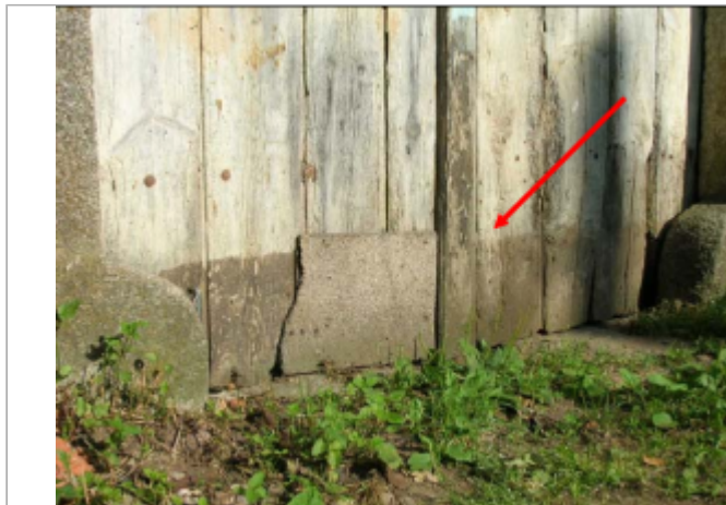
Garage du Moulin de Gastal
