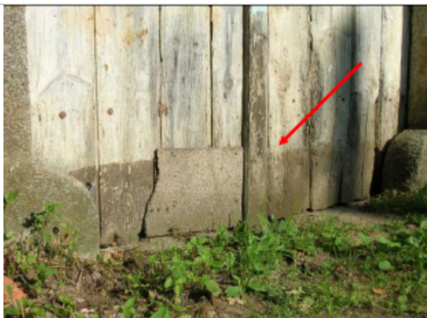
Garage de l'habitation au Moulin de Gastal
