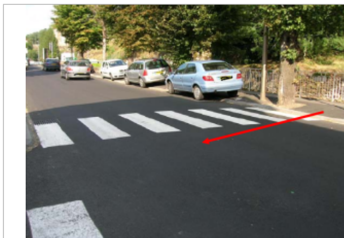
Repère niveau d'eau dans l'avenue Pierre Vialard
