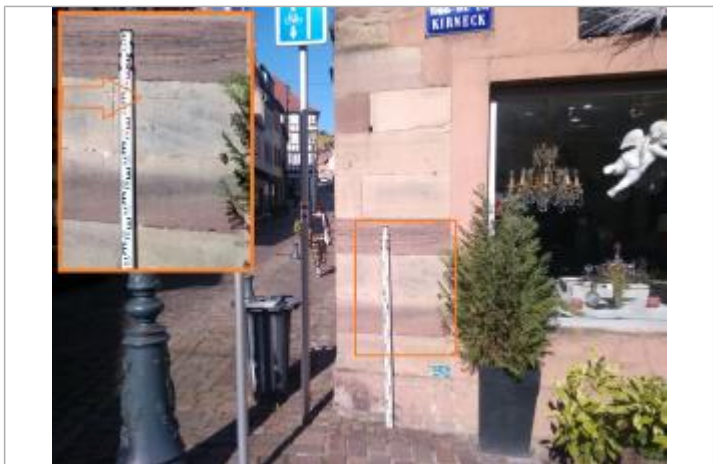
Vue de la pierre cornière avec repère de hauteur TN +1.55
