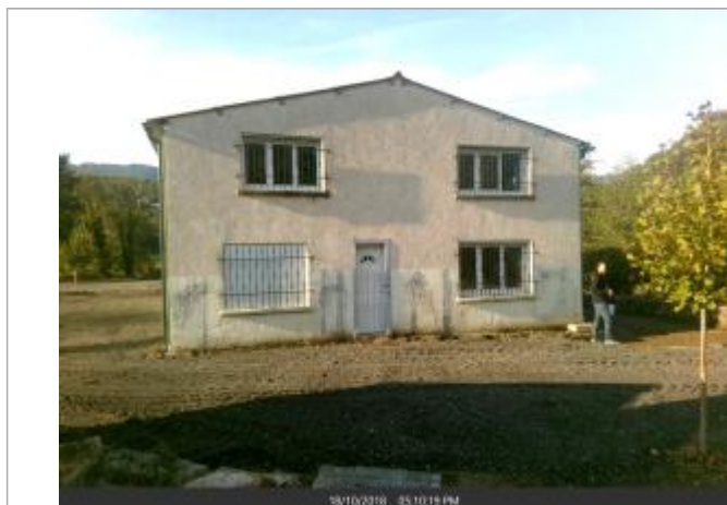
Angle droit du bâtiment, facade avec la porte d'entrée
