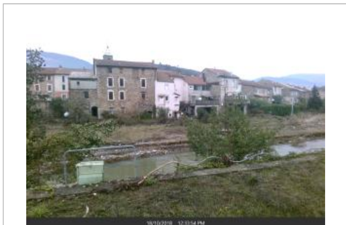
Mur de soutènement du jardin coté Jaur, au niveau de la caisse métallique
