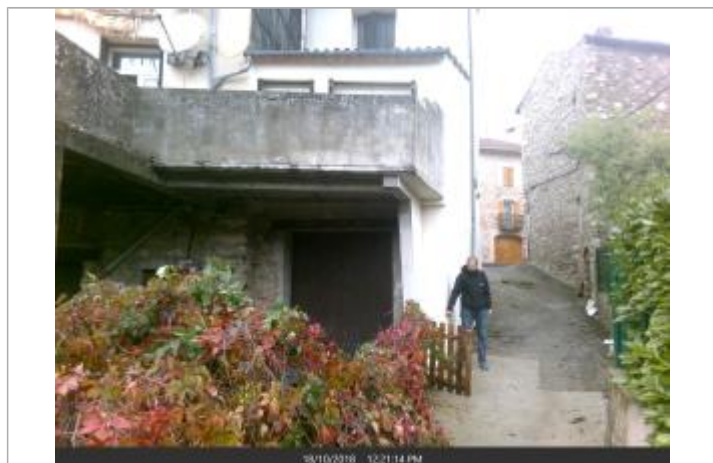
Mur à l'angle du bâtiment
