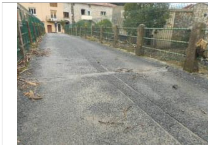
Grillage garde corps au centre du pont
