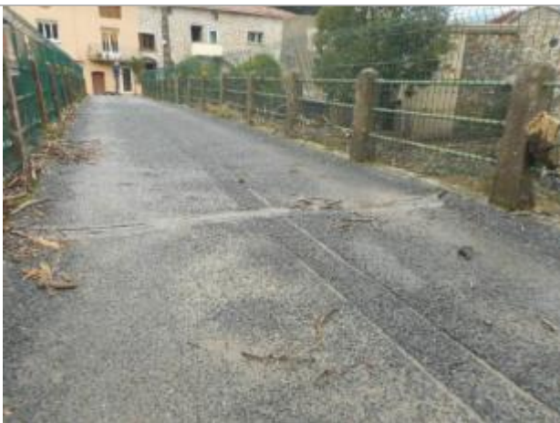
Grillage garde corps au centre du pont
