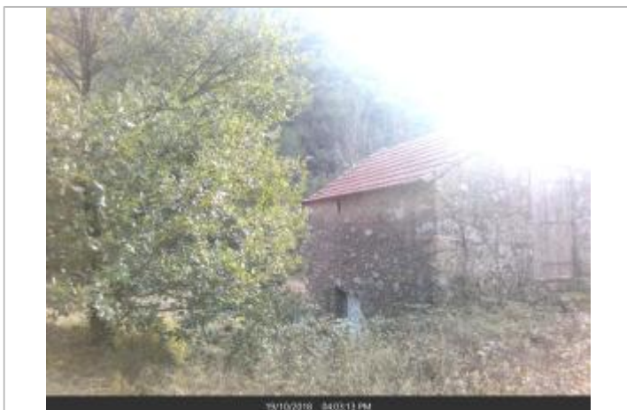
Porte d'entrée blanche du mazet située sur le coté Est
