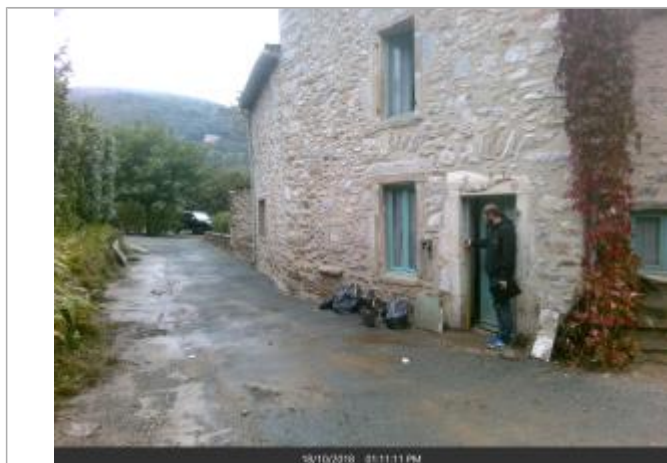
Porte d'entrée maison Mas du Moulin
