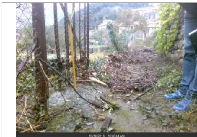
Gillage du mur de jardin, à proximité du portillon
