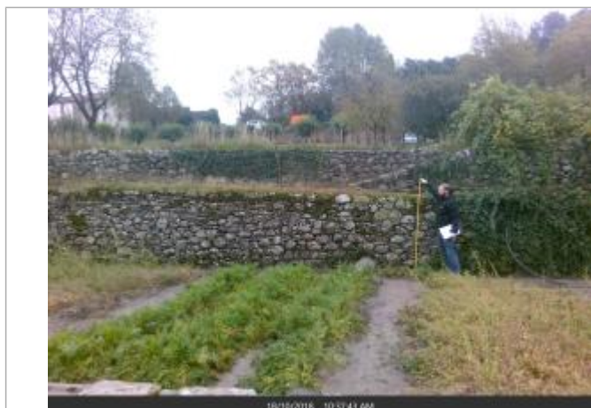
Mur de soutènement du jardin
