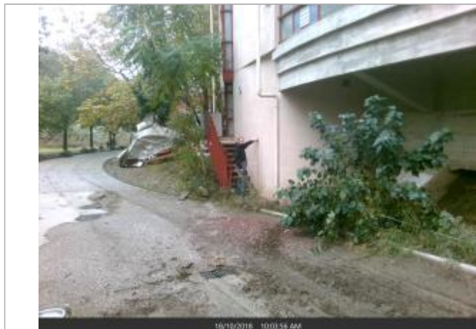
Mur au pied de l'escalier
