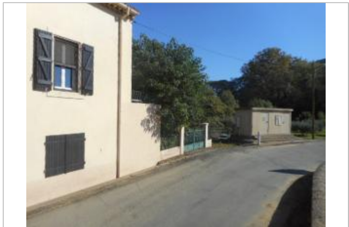
Angle de la maison en bordure de route coté transformateur
