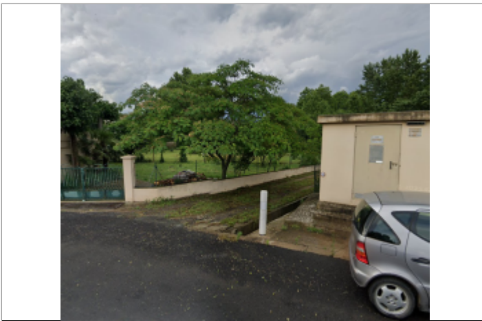
poste edf pierrerue
