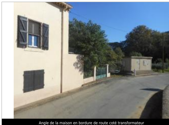
Angle de la maison en bordure de route coté transformateur
