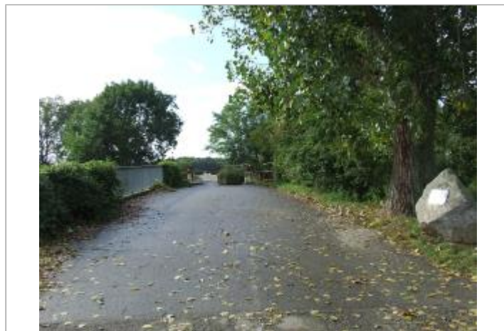
Vue générale du site
