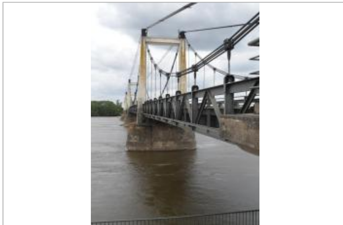
Pont de Montjean-sur-Loire
