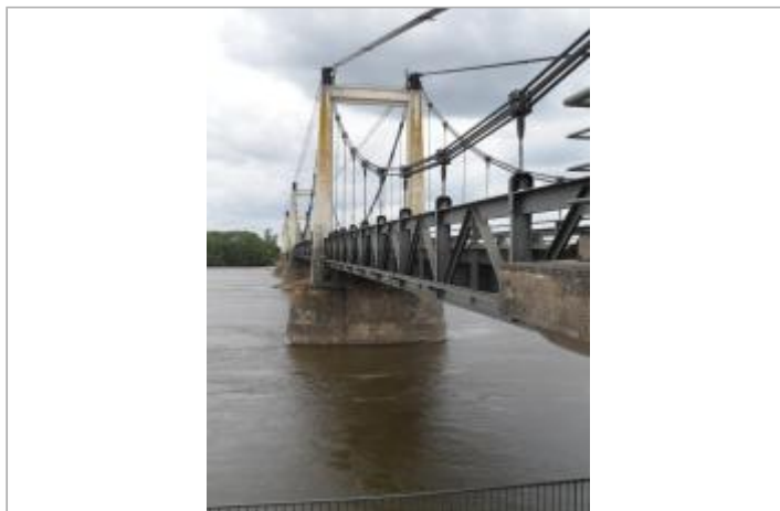
Pont de Montjean-sur-Loire
