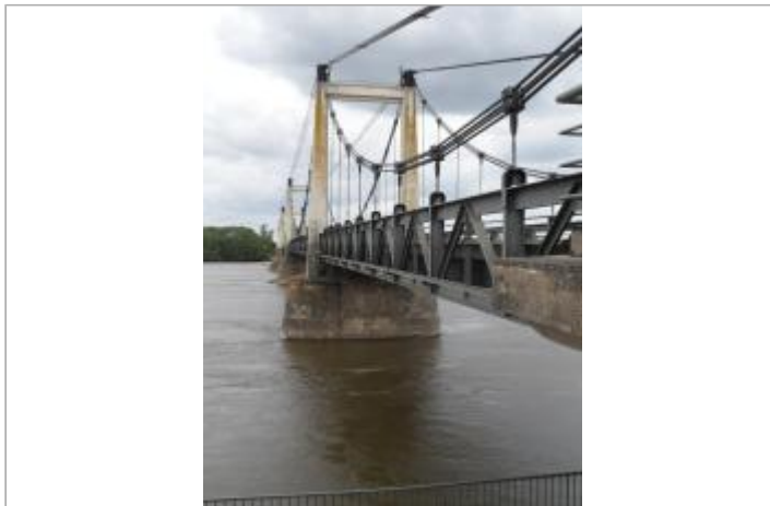
Pont de Montjean-sur-Loire
