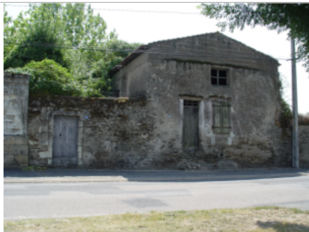
29 rue de la Basse rivière
