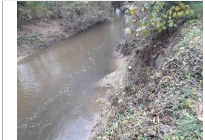
Vue du site
