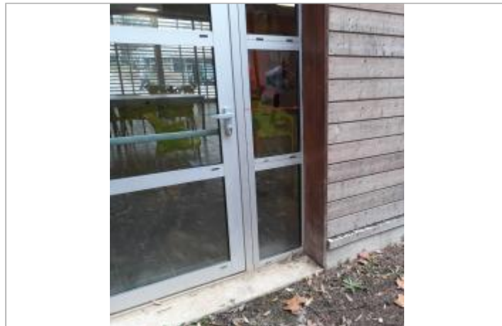
Vue du site
