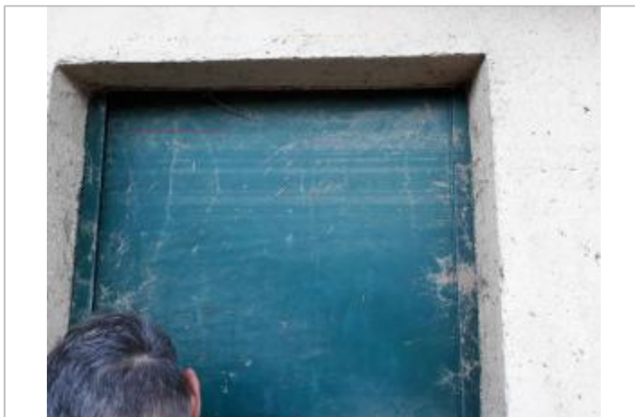
Vue du site
