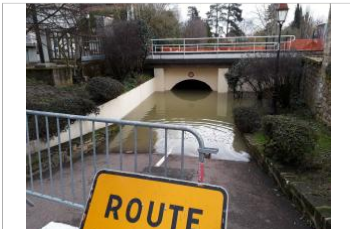
Passage sous voie ferrée amont gare
