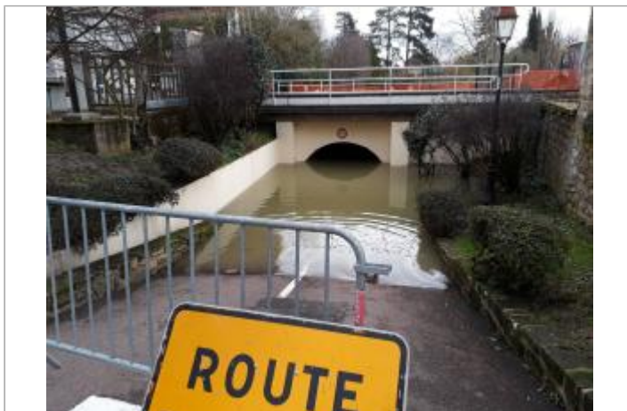
Passage sous voie ferrée amont gare
