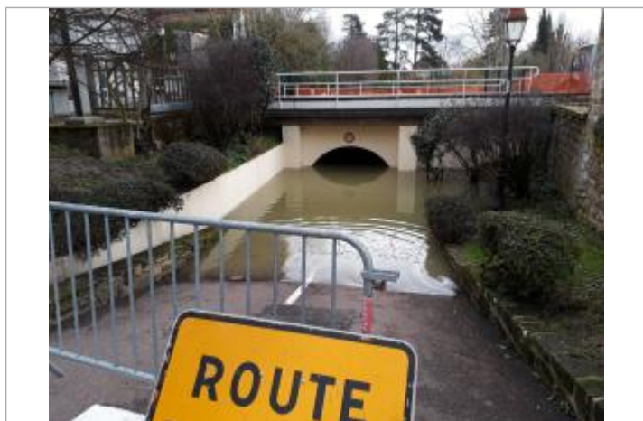
Passage sous voie ferrée amont gare
