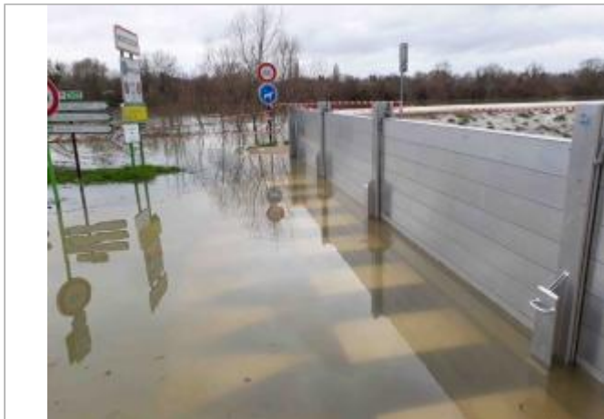
Crue de janvier 2018
