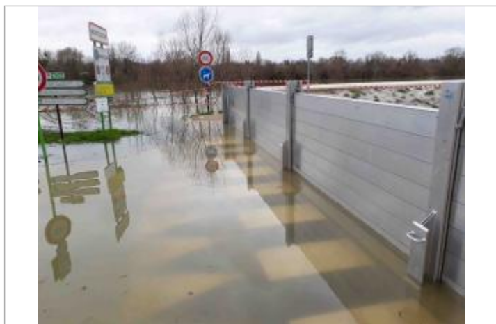
hauteur d'eau: +9 cm par rapport au pied du batardeau
