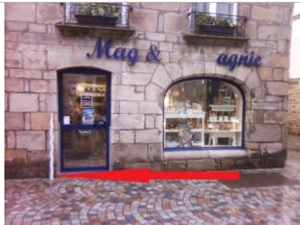
vue générale du site - magasin au n°20 rue René Madec
