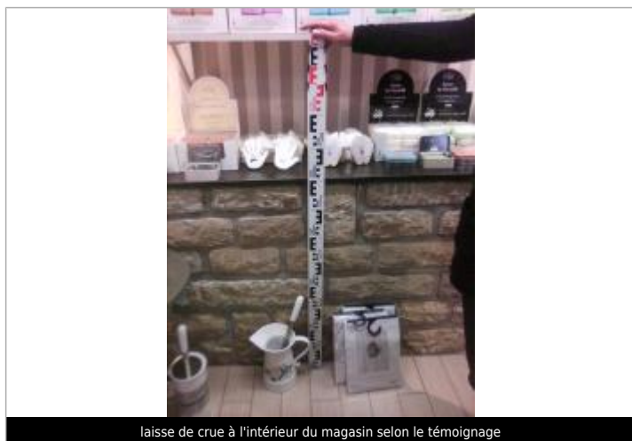
laisse de crue à l'intérieur du magasin selon le témoignage
