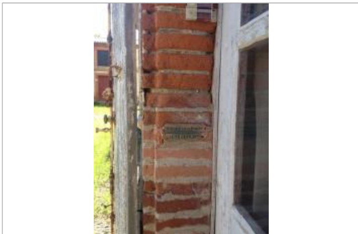
Vue du repère ( Photo Jean CHABAUD)
