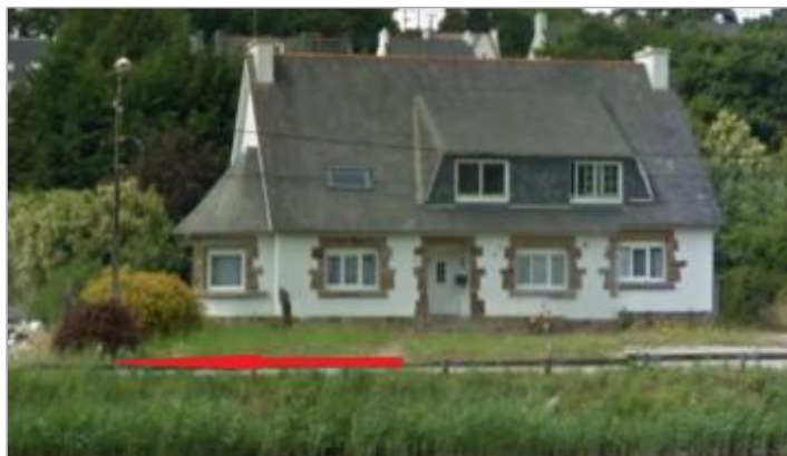
vue générale du site - report au niveau du poteau électrique bord de route
