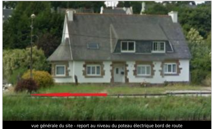
vue générale du site - report au niveau du poteau électrique bord de route
