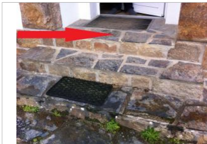
repère nivelé au niveau de la maison
