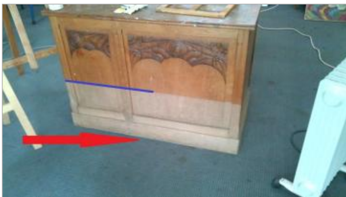
Laisse de crue à l'intérieur de l'atelier
