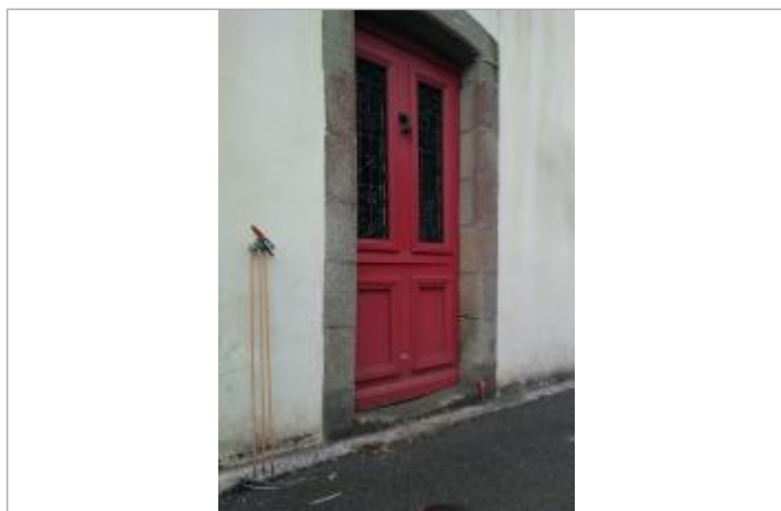
point de nivellement extérieur - seuil porte d'entrée coté droit à l'angle du mur sur partie pavé
