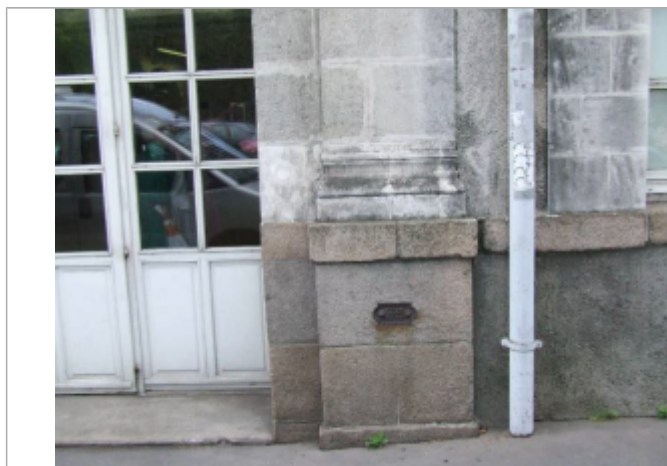
21 Allée Baco / les Bains douches
