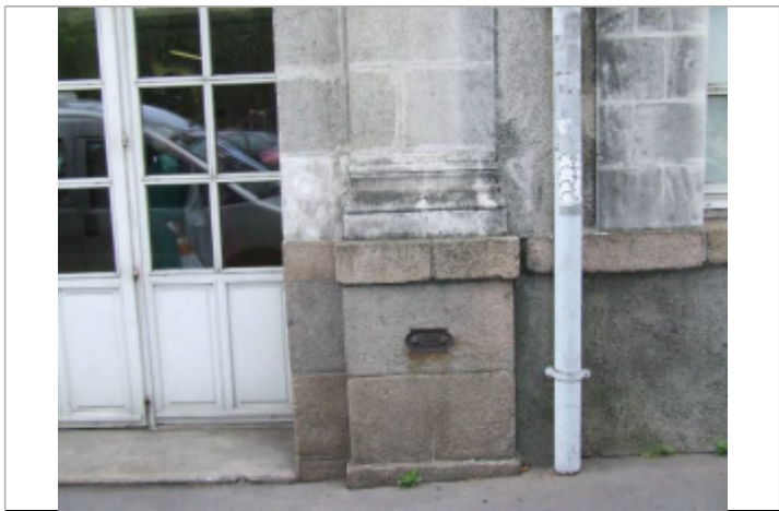
21 Allée Baco / les Bains douches
