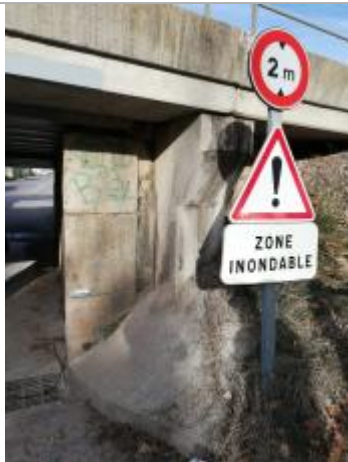
Passage sous voie ferrée
