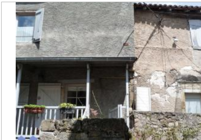
vue rapprochée de la maison sur laquelle se situe le repère
