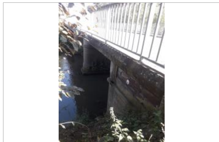
Amont pont RD32
