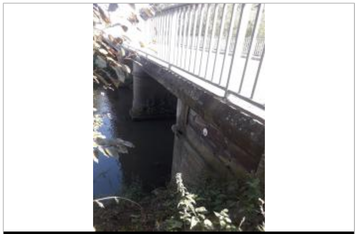
Amont pont RD32
