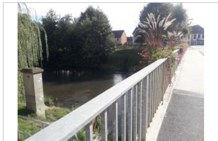
Amont Pont rue de la gare
