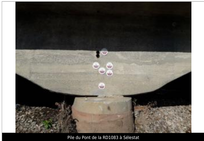
Pile du Pont de la RD1083 à Sélestat
