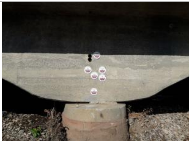
Pile du Pont de la RD1083 à Sélestat
