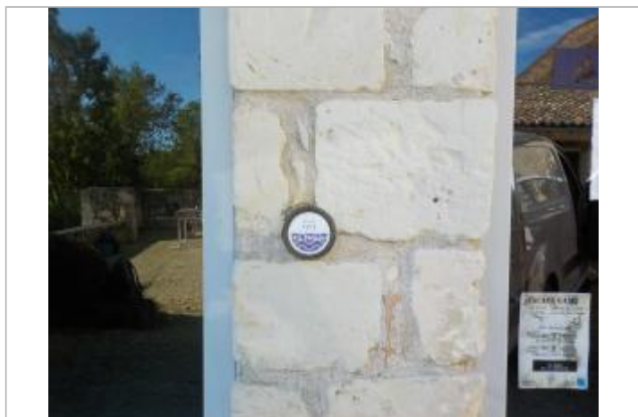
Photos du repère VOUN49-R. Source : 3DI
