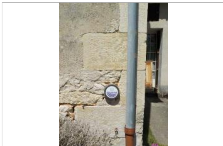
Photos du repère VALD63-R. Source : 3DI
