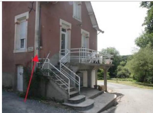
Photos du site VALD62-R. Source : EPTB Vienne
