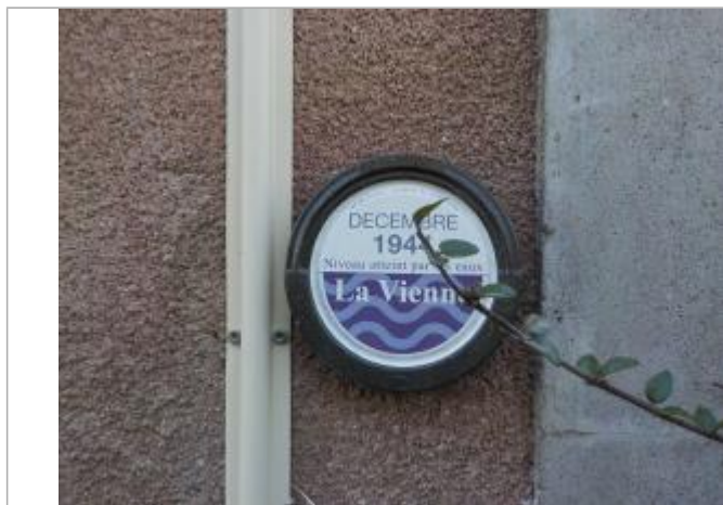
Photos du repère VALD62-R. Source : 3DI
