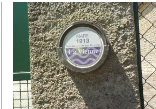
Photos du repère VALD61-R. Source : 3DI
