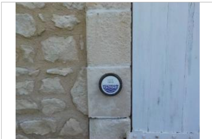
Photos du repère VALD59-R. Source : 3DI
