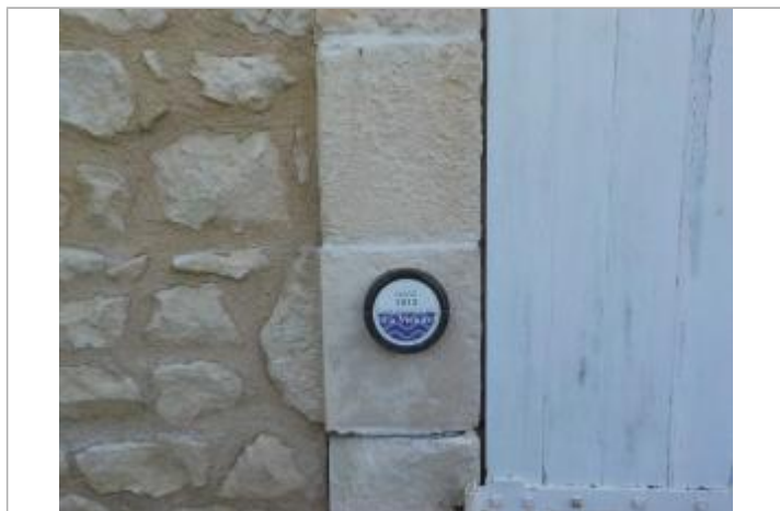
Photos du repère VALD59-R. Source : 3DI
