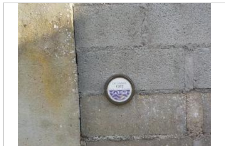
Photos du repère NAIN30-R. Source : 3DI
